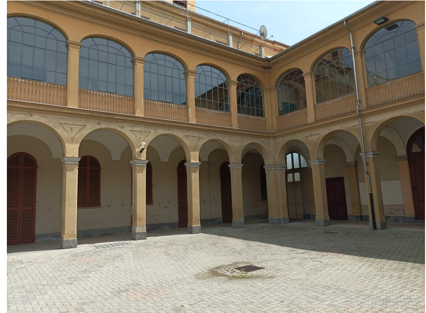
Exterior de l'escola
