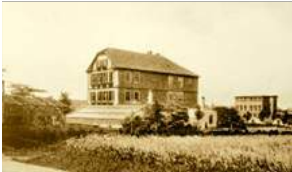
Ahlem el 1924, edifici central
