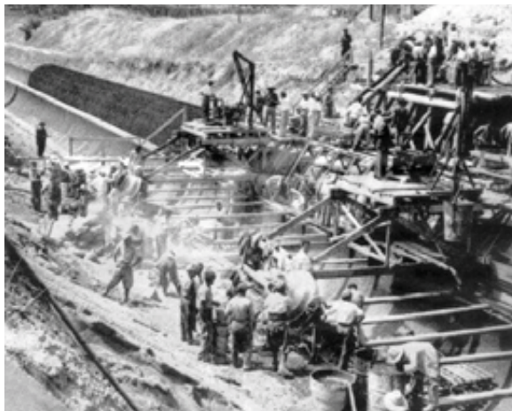
Construcció del canal del Baix Guadalquivir, conegut com el "canal dels presos" ja que va ser construït amb presos polítics. Font: Eldiario.es
